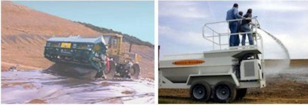
Kuva 22. Peittomenetelmiä a) ECS-kalvomenetelmä b) Ruiskutusmenetelmä
